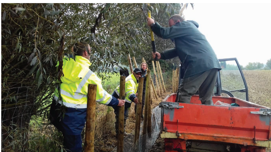
Placement des piquets pour fascines de paille à Tubize - ©CRSenne
