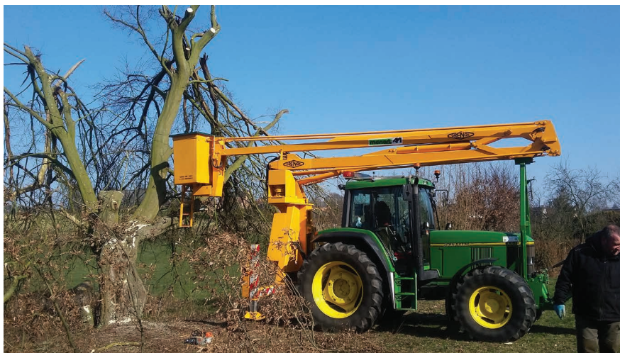
Aide aux travaux sur la commune de Seneffe - ©CRSenne
