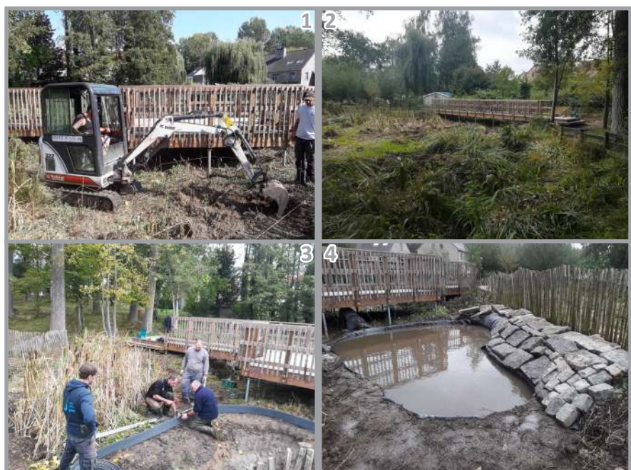
1 et 2 : zone humide avant et après travaux
