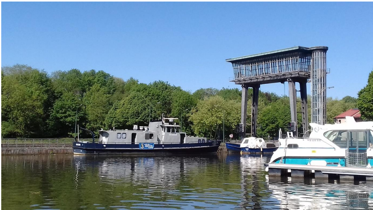
Figure 13 : écluse 5 F du canal Charleroi-Bruxelles (Ittre) ©CRSenne
