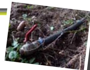
Étape 3 : couper la longueur de socarex nécessaire pour rejoindre la berge, tremper le socarex dans de l'eau chaude pour le ramollir et le fixer à la tétine à l'aide du collier de serrage. Placer le té HUOT à l'autre extrémité
