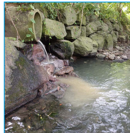
Égout/collecteur non raccordé ©CRS
