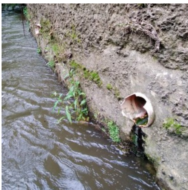
Égout/collecteur non raccordé ©CRS
