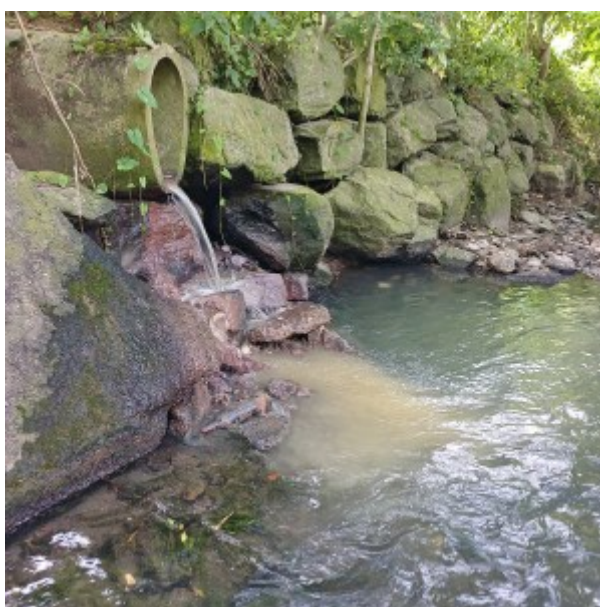
Égout/collecteur non raccordé ©CRS
