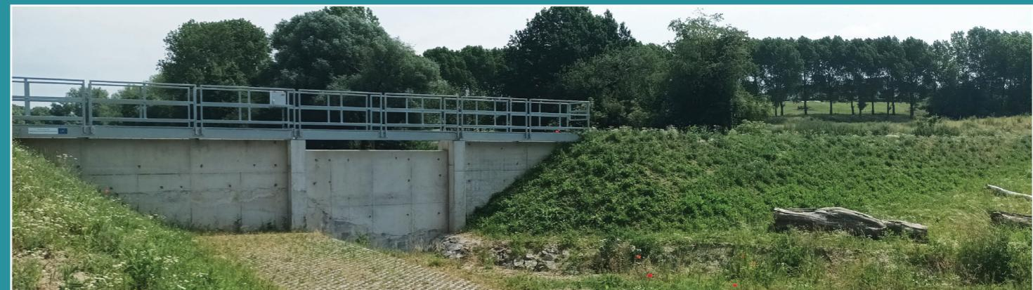
Une **zone d'immersion temporaire (ZIT)** est un aménagement qui permet de stocker temporairement un volume d'eau lors d'un évènement pluvieux important (orages, pluies continues et persistantes, etc.) afin de **limiter les inondations** en aval, et de permettre de relâcher les eaux progressivement par la suite. La ZIT de Gaesbecq se situe sur le cours d'eau du Ry Ternel avant le centre d'Ittre et stocke environ **51 600 m<sup>3</sup>**.
