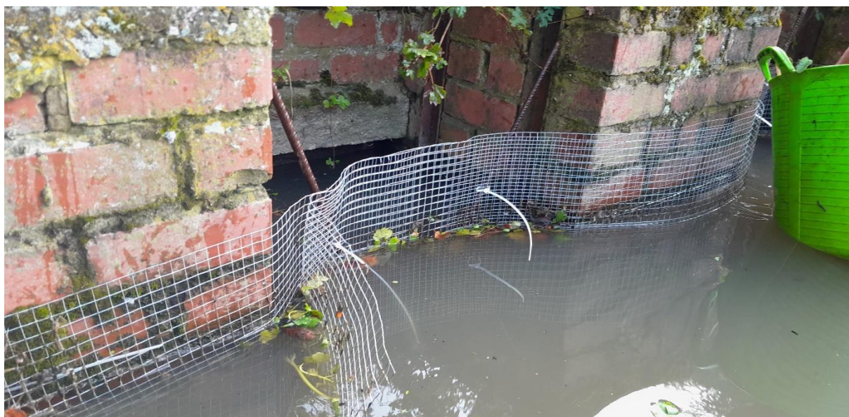
Figure 13 – Dans ce cas-ci, un grillage adapté a été installé au niveau de l'exutoire afin de retenir les fragments d' Hydrocotyle fausse-renoncule ( Hydrocotyle ranunculoides ).
