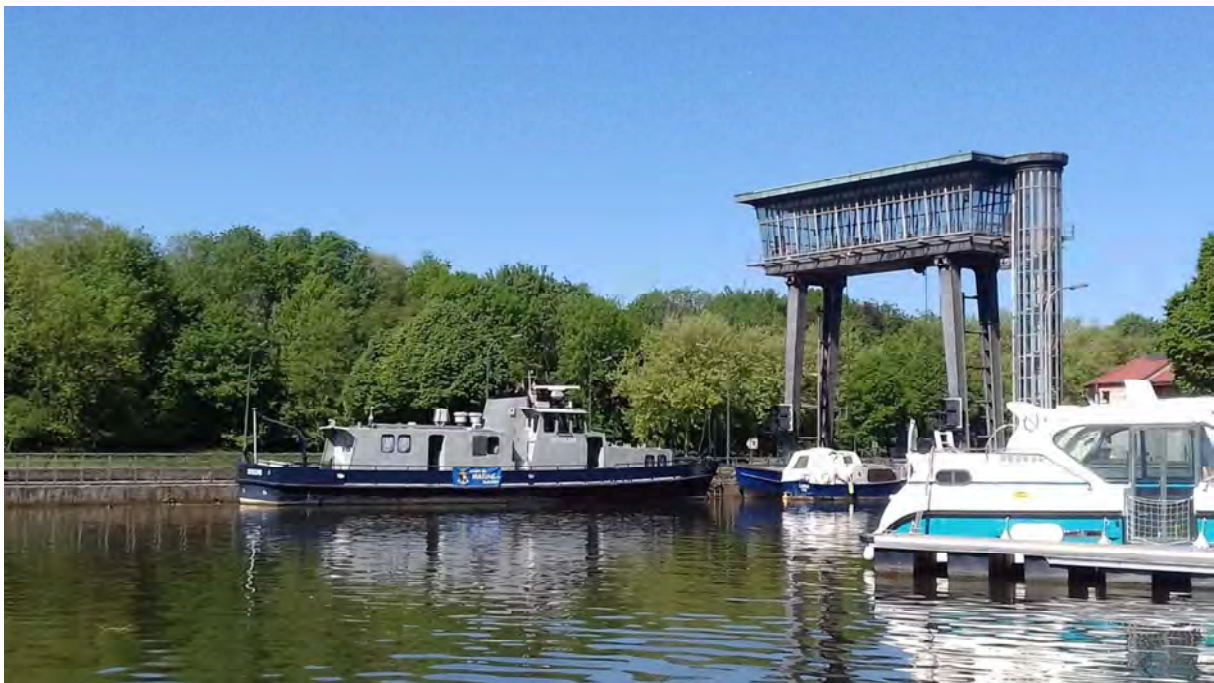
Figure 15 : écluse 5 F du canal Charleroi-Bruxelles (Ittre) ©CRSenne
