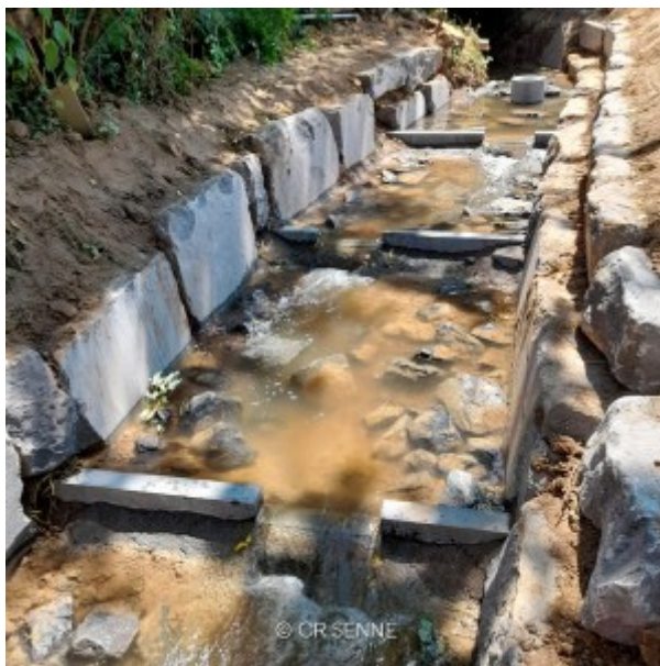
Création d'une échelle à poissons dans un cours d'eau ©CRSenne
